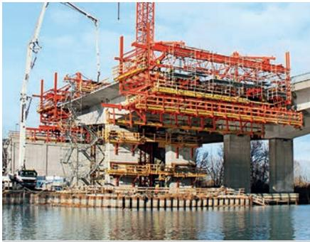
**Encofrados para puentes con el sistema modular para obras de ingeniería VARIOKIT**
